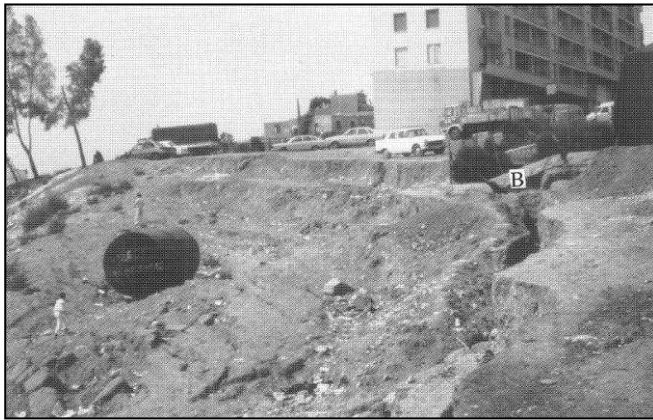
Photo 1 – Niche d'arrachement du glissement du Ciloc (B = pied du bâtiment B) / Scar of the Ciloc landslide (B = building foot).
